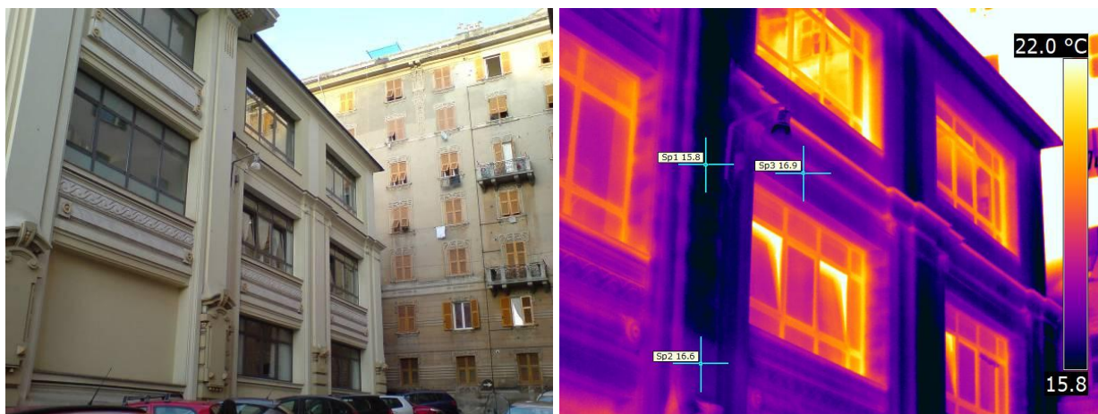
Figura 4.3 – Rilievo termografico della parete del fronte sud in via Botticelli
