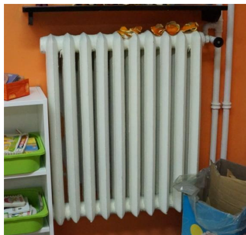
Figura 8.5 – Particolare terminali di emissione
