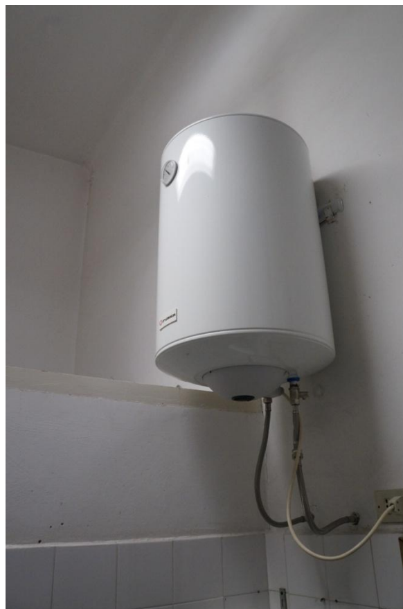
Figura 4.11 - Particolare di un boiler elettrico per la produzione di acqua calda sanitaria
