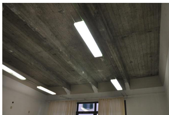
Figura 4.2 - Particolare del solaio in alcune aule privo di controsoffitto
